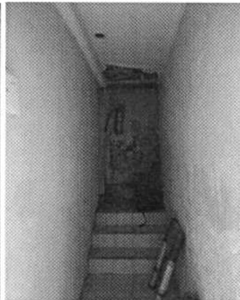
Photo 4 : ACCES BÂT B R+1
